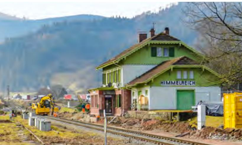
Im Bahnhof Himmelreich bleibt praktisch kein Stein auf dem anderen. Bahnsteige, Zugänge, Gleise und Oberleitungen werden von Grund auf saniert und modernisiert.
