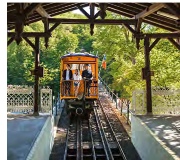
Ankunft in der Talstation: Der bergab fahrende Wagenführer regelt die Geschwindigkeit der Bahn. Die Zahnräder unter dem Waggon greifen in die Zahnstange und sichern das Fahrzeug.
