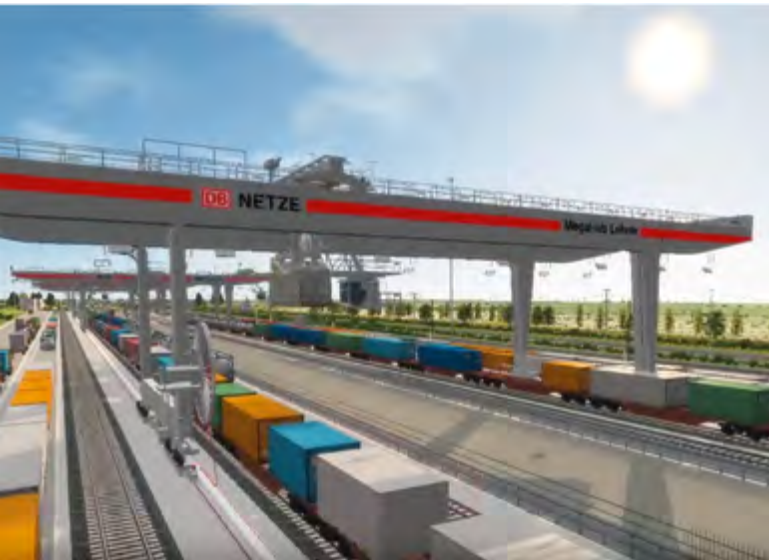
Visualisierung: Die Anlage sammelt Ladeeinheiten für den kombinierten Verkehr und verteilt sie schnell auf Ganzzüge für die jeweilige Zielregion.
