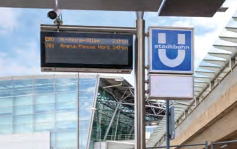
Blick aus dem Führerstand auf die neue, 450 Meter lange Brücke über den Nordstern. Von der U-Bahn-Station sind es nur wenige Schritte bis ins Terminal (u.).
